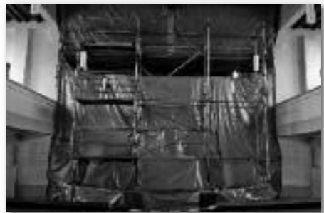
Einrüstung über die Kanzel und Orgelepore hinaus, staubdichte Verpackung der kompletten Orgel (unten).
